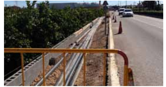
Accés peatonal a la carretera
